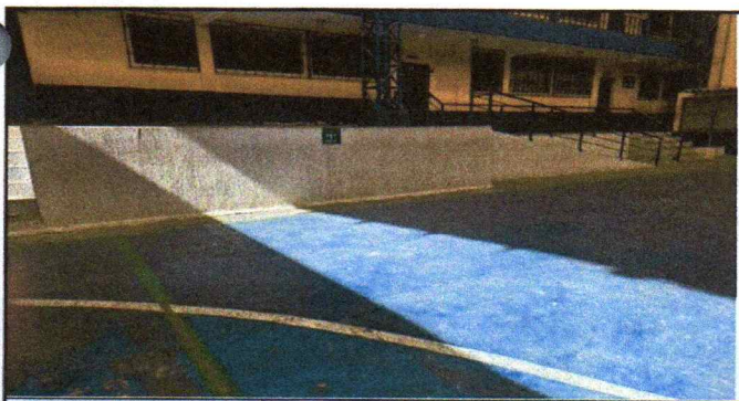
SUMINISTRO Y APLICACIÓN DE PINTURA DE ACEITE PARA GRADAS EXTERIOR (MODULO CANCHA) 25 m2
