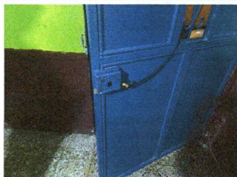
SUSTITUCIÓN DE CHAPA YALE EN PUERTA DE METAL (INCLUYE DESMONTAJE DE ANTIGUA) 1 unidad.
