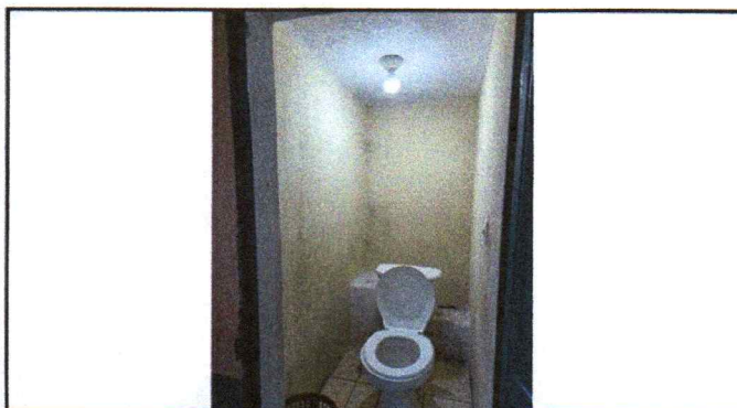
SUMINISTRO Y APLICACIÓN DE PINTURA PARA BAÑOS (MODULO SERVICIO SANITARIO) 65 m2
