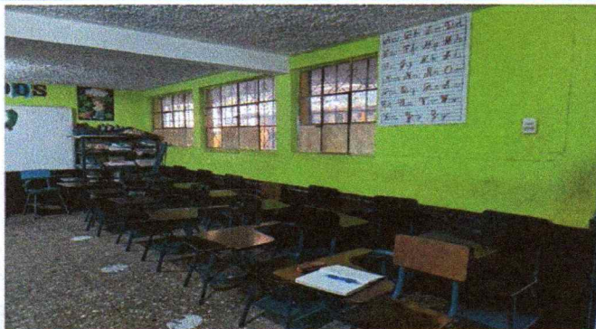
SUMINISTRO Y APLICACIÓN DE PINTURA PARA 17 AULAS PAREDES CON ZOCALO PINTURA DE ACEITE (MODULO A Y B). 1220 m2
