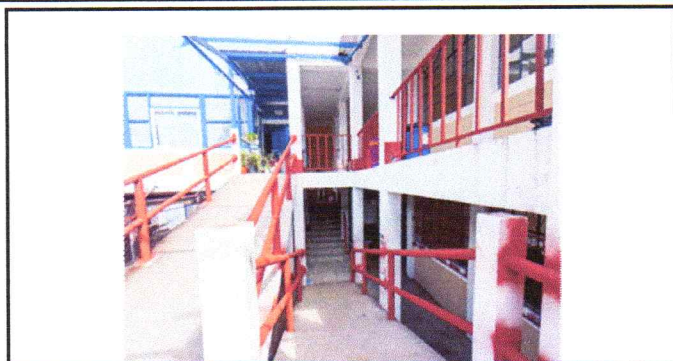
REGLÓN 7. Mantenimiento y aplicación de pintura en barandales, pasamanos de rampa y segundo nivel. 40 mts lineales
