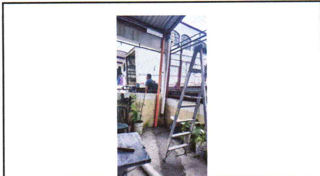
REGLÓN 8. Mantenimiento y sustitución de canal de agua pluvial y tubo de PVC de 4 pulgadas 16 ml. Primer nivel.
