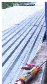
REGLÓN 3. Mantenimiento y sustitución de lámina troquelada calibre 26 sobre rampa. 46 mts2
