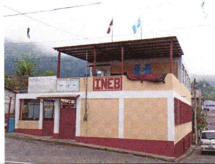
REGLÓN 2. Mantenimiento y sustitución de cubierta de lámina troquelada calibre 26 en el segundo nivel. 54 mts2
