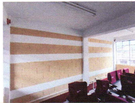
REGLÓN 4. Suministro y aplicación de pintura en muros interiores y exteriores en losa. 920 mts2
