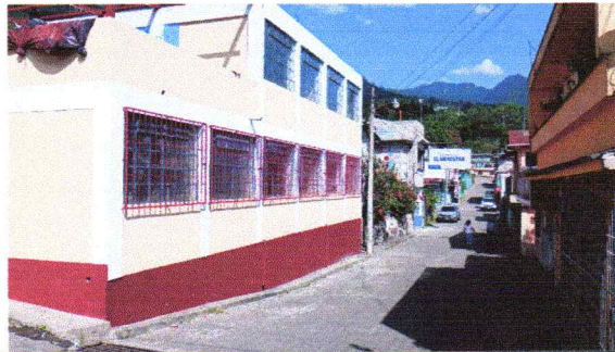
REGLÓN 6. Mantenimiento y aplicación de pintura en balcones interiores y exteriores. 39 mts2
