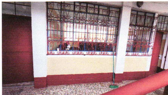
REGLÓN 5. Mantenimiento y aplicación de pintura en puertas interiores y exteriores (lijado, pintura). 15 puertas
