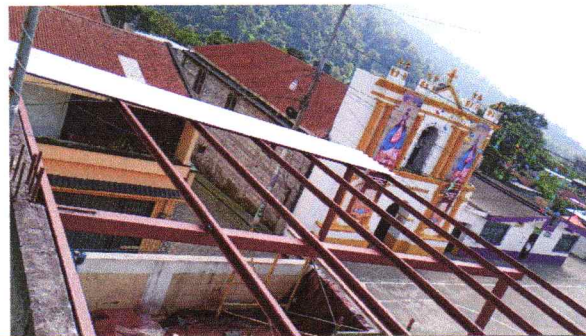
REGLÓN 2. Mantenimiento y sustitución de cubierta de lámina troquelada calibre 26 en el segundo nivel. 54 mts2
