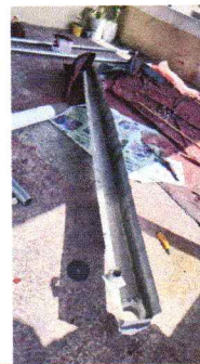
REGLÓN 8. Mantenimiento y sustitución de canal de agua pluvial y tubo de PVC de 4 pulgadas 16 ml. Primer nivel.
