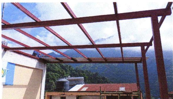
REGLÓN 1. Mantenimiento y sustitución de estructura en el Segundo Nivel con tubos de 4X4 y costaneras de 2X3. 54 mts2
