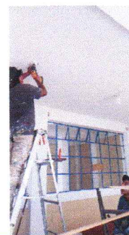
REGLÓN 10. Mantenimiento correctivo del sistema de iluminación por focos ahorrativos en: Aulas, corredores del primer y segundo nivel. 36 focos.
