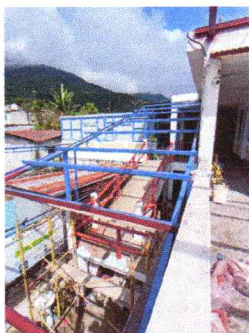
REGLÓN 3. Mantenimiento y sustitución de lámina troquelada calibre 26 sobre rampa. 46 mts2
