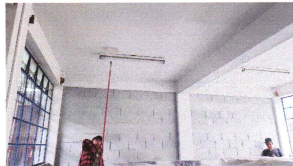
REGLÓN 4. Suministro y aplicación de pintura en muros interiores y exteriores en losa. 920 mts2
