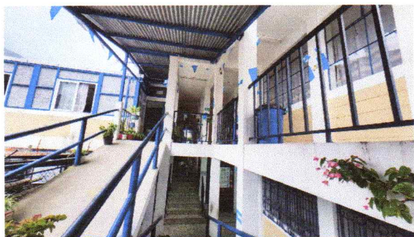
REGLÓN 7. Mantenimiento y aplicación de pintura en barandales, pasamanos de rampa y segundo nivel. 40 mts lineales
