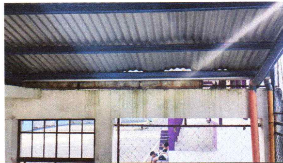
REGLÓN 8. Mantenimiento y sustitución de canal de agua pluvial y tubo de PVC de 4 pulgadas 16 ml. Primer nivel.
