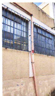
REGLÓN 9. Mantenimiento y sustitución de tubos en bajadas de agua pluvial PVC de 4 pulgadas (accesorios y abrazaderas). 16 mts lineales
