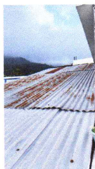
REGLÓN 3. Mantenimiento y sustitución de lámina troquelada calibre 26 sobre rampa. 46 mts2
