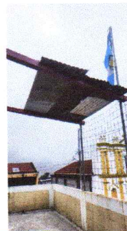
REGLÓN 2. Mantenimiento y sustitución de cubierta de lámina troquelada calibre 26 en el segundo nivel. 54 mts2
