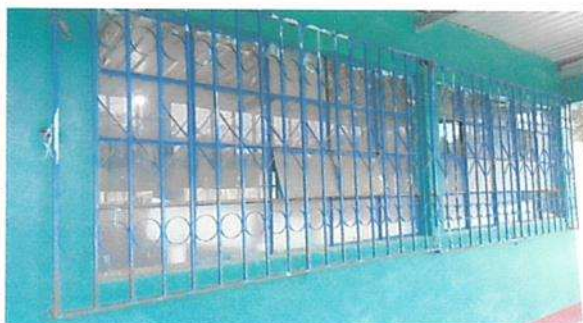
Sustitución de balcones en módulo 3.
