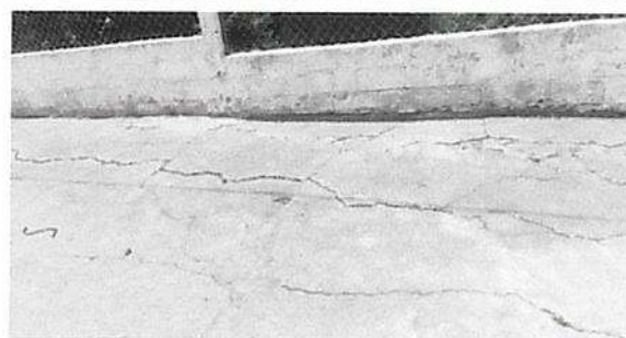
Sustitución de plancha de concreto en patio
