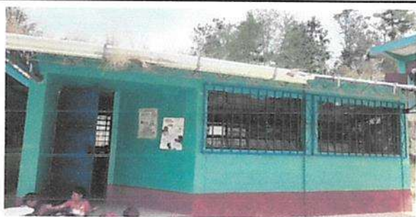
Sustitución de canal de pvc y bajada de agua pluvial por pvc en módulo 2 y 4
