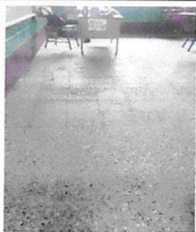
Sustitución de piso de granito por piso porcelanato en módulo 2
