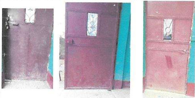
Sustitución de puertas metálicas en módulo 1 y 3
