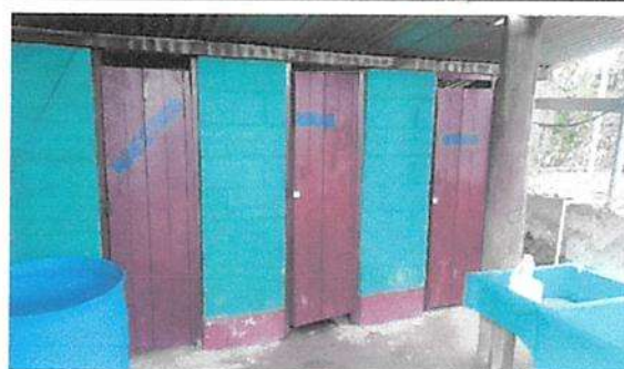
Sustitución de puerta de servicios sanitarios.
