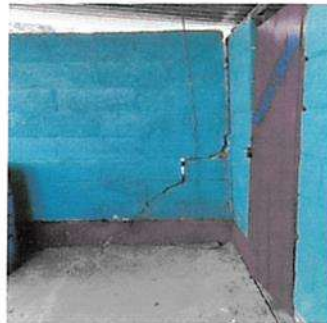
Sellado de grietas y fisuras en pared de block en sanitarios
