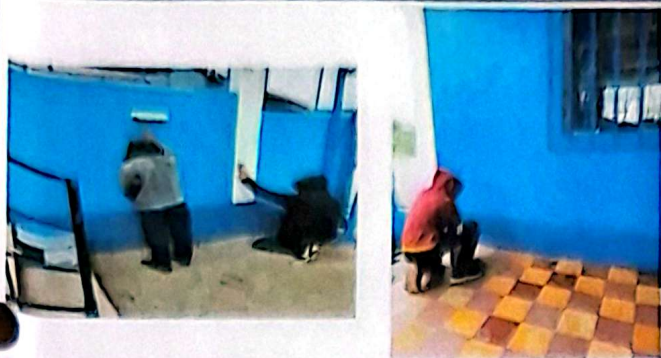
Foto 1: Aplicación de 1,350 metros cuadrados de pintura exterior en muros y paredes exterior, interior en aulas, dirección y baños exterior e interior.
