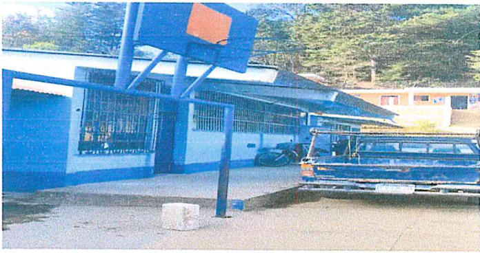
Foto1: Suministro y aplicación de pintura exterior latex celeste panton 293 para zócalo modulo 1 y 2
