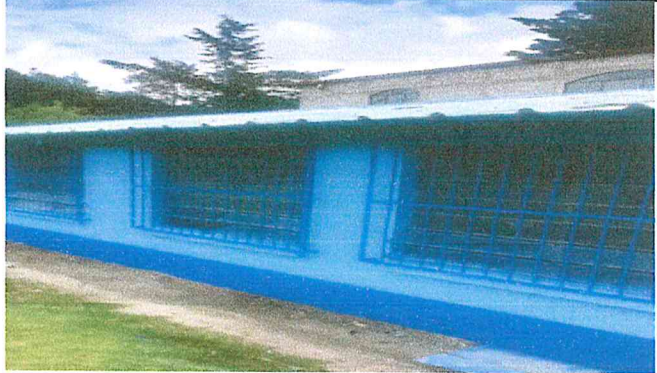
Foto 2: Suministro y aplicación de pintura exterior latex celeste panton 293 para muros modulo 1 y 2
