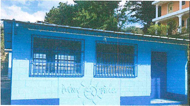
Foto1: Suministro y aplicación de pintura exterior latex celeste panton 293 para muros modulo 1 y 2
