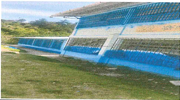
Foto 2: Suministro y aplicación de pintura exterior latex celeste panton 293 para muros modulo 1 y 2
