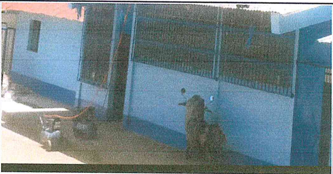
Foto 4: Suministro y aplicación de pintura exterior latex celeste panton 293 para muros modulo 1 y 2
