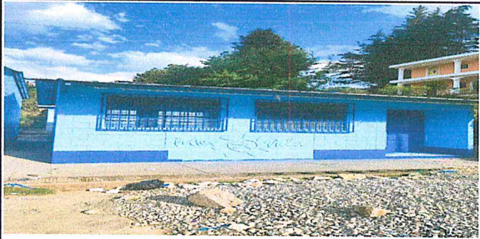
Foto1: Suministro y aplicación de pintura exterior latex celeste panton 293 para muros modulo 1 y 2
