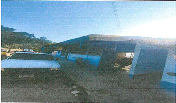
Suministro y aplicación de pintura exterior latex celeste panton 293 para z
