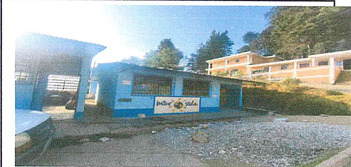
Suministro y aplicación de pintura exterior latex celeste panton 293 para muros modulo 1 y 2
