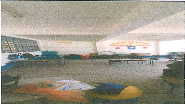
Suministro y aplicación de pintura interior latex lavable (limpieza, resane y aplicación). Modulo 2
