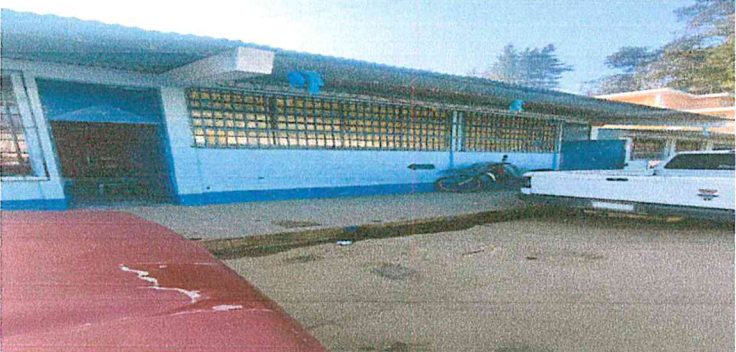
Suministro y aplicación de pintura exterior latex celeste panton 293 para zocalo modulo 1 y 2
