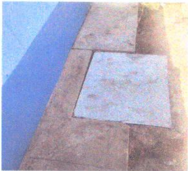
Mantenimiento de drenaje para la cocina
