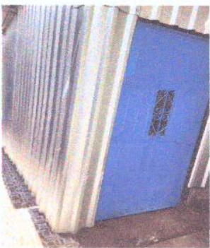
Foto 2: Sustitución de puerta de madera a metal
