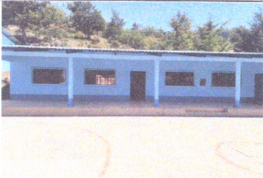
Mejoramiento de pared con pintura sherwin williams adentro y afuera
