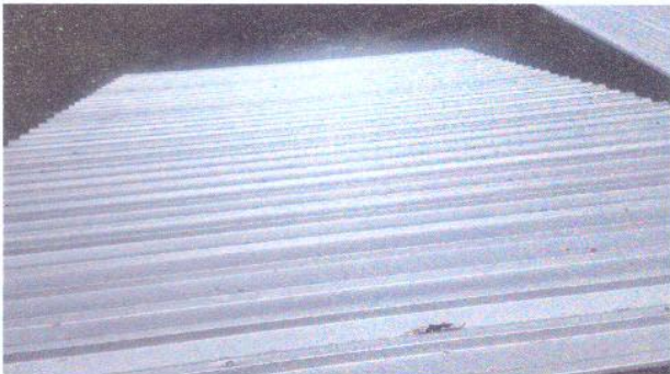
Foto 4: Sustitución de lamina acanalada por lamina troquelada Feromax.
