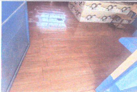
Sustitución de piso torta de cemento por ceramico
