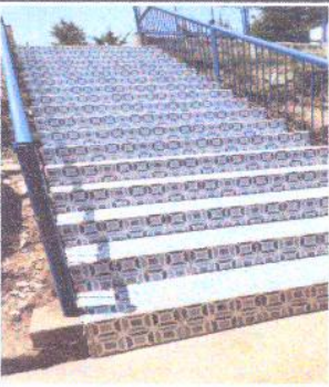
Foto 6: Mantenimiento de grada de concreco a ceramico antideslizante
