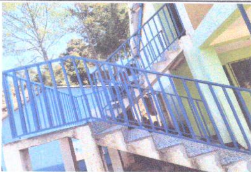
Mantenimiento lineales de baranda de metal con pintura anticorrosiva que va al segundo nivel.
