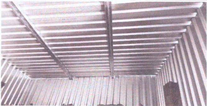
Foto 3: Sustitución de estructura portante de madera a estructura metal galvanizado.
