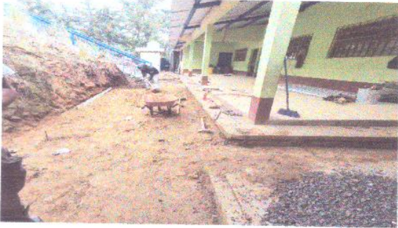
Foto 5: Sustitución de torta de cemento a concreto para patio.
