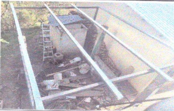
Foto 3: Sustitución de estructura portante de madera a estructura metal galvanizado.
