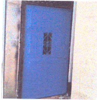
Foto 2: Sustitución de puerta de madera a metal
