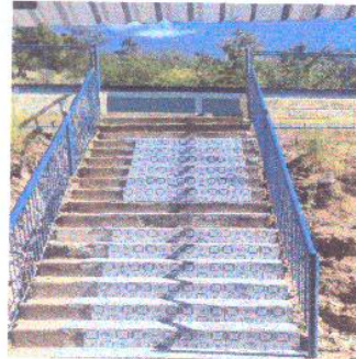
Foto 6: Mantenimiento de grada de concreto a ceramico antideslizante
