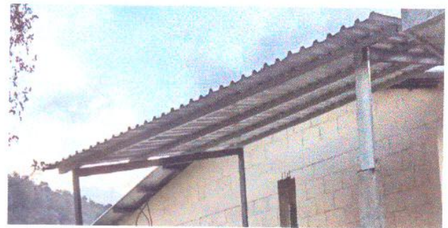
Foto 4: Sustitución de lamina acanalada por lamina troquelada Feromax.
