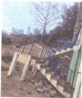
Mantenimiento lineales de baranda de metal con pintura anticorrosiva que va al segundo nivel.
