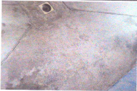
Sustitución de piso torta de cemento por cerámico
