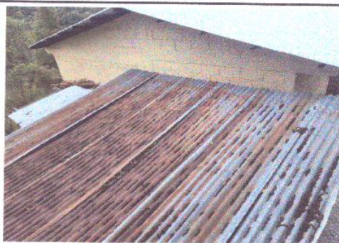
Sustitucion de lamina acanalada por lámina troquelada Ferromax
