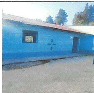
Mantenimiento de cubierta de lámina incluye lijado y aplicación de pintura anticorrosiva aulas módulo 1
