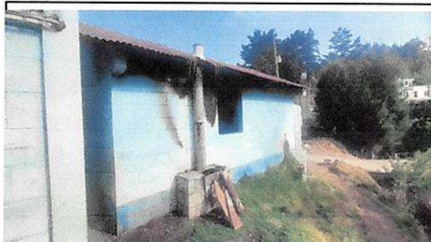
Sustitución de dos chimeneas de ladrillo en cocina módulo 1
