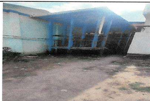
Mantenimiento de barandas de metal en aulas módulo 2
