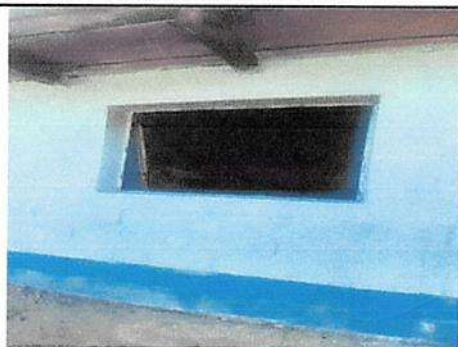
Sustitución estructura de metal de ventana en cocina módulo 1
