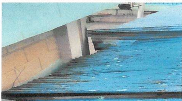
Sustitución de lámina, por lámina troquelada 0.38 Calibre 26"
