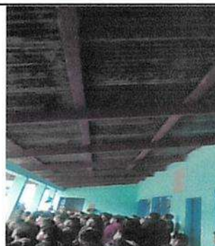
Sustitución de estructura de soporte de madera por metal tubo cuadrado de 3"x2"
