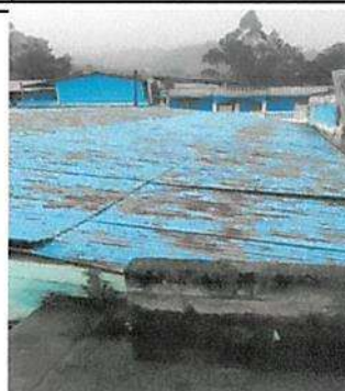
Sustitución de lámina, por lámina troquelada 0.38 Calibre 26"
