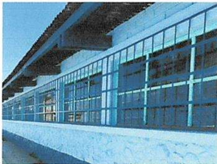
Sustitución de ventanas por ventanas de UPVC serie 80, con vidrio claro de 5mm.
