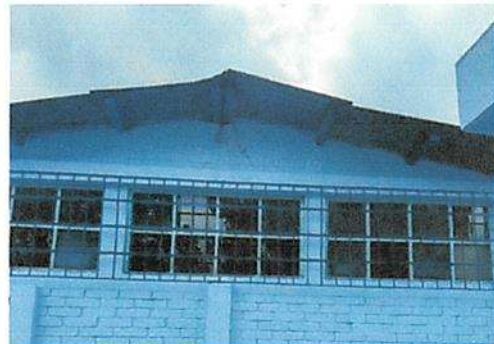
Sustitución de ventanas por ventanas de UPVC serie 80, con vidrio claro de 5mm.
