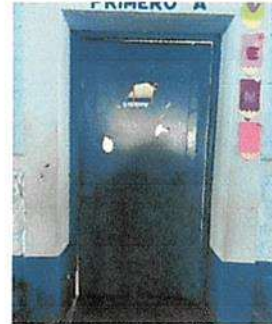
Sustitución de puertas de metal con tubo cuadrado de 1.5 pulgadas, con lamina estampada de 3/64
