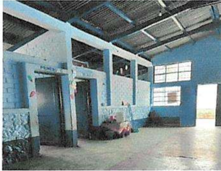
Sustitución de puertas de metal con tubo cuadrado de 1.5 pulgadas, con lamina estampada de 3/64
