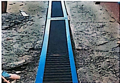
Foto1: Sustitución de 16 Mts. de manejo de agua pluvial existente con tubo PVC. de 4" por manejo de agua pluvial con canal U de concreto y regía de metal en el módulo 1
