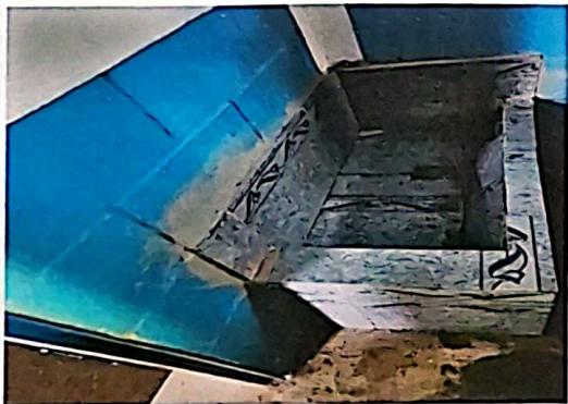
Foto 3: Mantenimiento a 1 migitorio con azulejo en baño, módulo 1
