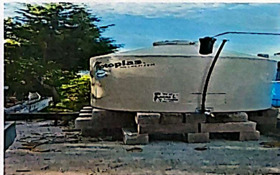
Foto 6: Sustitución de 1 deposito de agua 2500 lts. Más instalación en módulo 2
