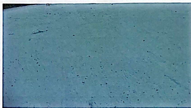
Foto 4: Mantenimiento correctivo de 86 Mts. Cuadrados de losa de concreto con nivelación de terraza para aplicación de impermeabilizante (relleno de grietas y desnivel) en módulo 2
