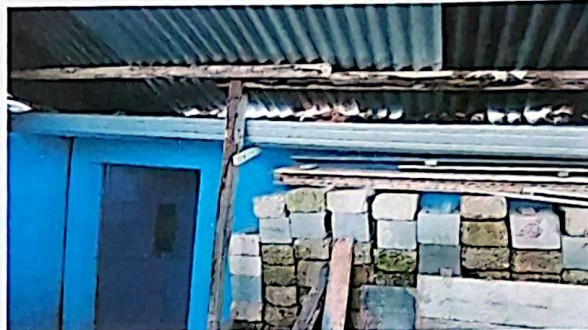
Foto 2: Sustitución de 22 Mts. de canal de PVC. Por canal de metal en módulo 1
