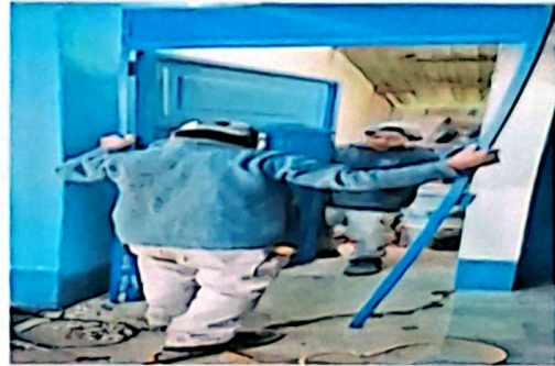
Foto 10: Sustitución de 1 puerta de bodega de madera por 1 puerta metálica en módulo 2
