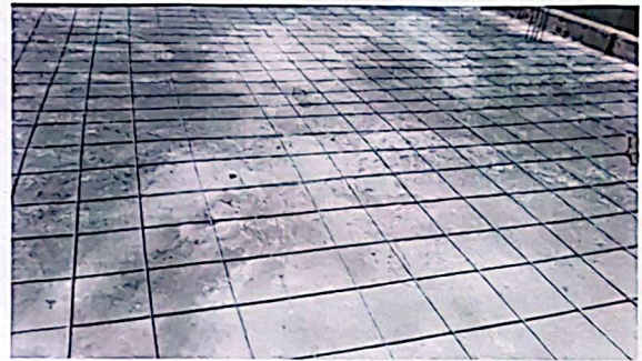
Foto 4: Mantenimiento correctivo de 86 Mts. Cuadrados de losa de concreto con nivelación de terraza para aplicación de Impermeabilizante (relleno de grietas y desnivel) en módulo 2
