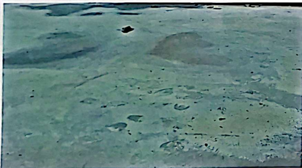
Foto 5: Mantenimiento correctivo de 86 Mts. Cuadrados de losa con impermeabilizante con bloqueador de agua aqualock 10 años, en 1 aula del módulo 2
