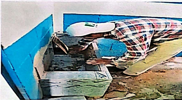
Foto 3: Mantenimiento a 1 migitorio con azulejo en baño, módulo 1
