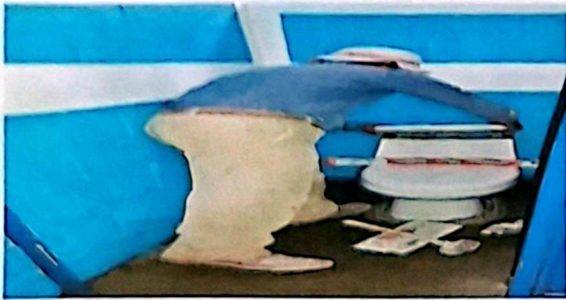
Foto 9: Sustitución de 1 inodoro elongado en módulo 1
