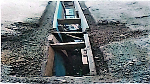
Foto1: Sustitución de 16 Mts. de manejo de agua pluvial existente con tubo PVC. de 4" por manejo de agua pluvial con canal U de concreto y regla de metal en el módulo 1
