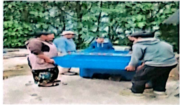
Foto 8: Sustitución de 1 pila en cocina en módulo 2
