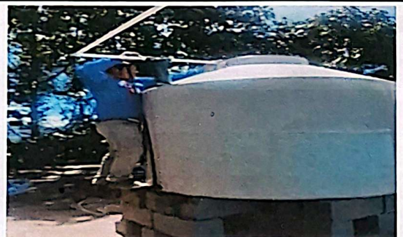
Foto 6: Sustitución de 1 deposito de agua 2500 lts. más instalación en módulo 2
