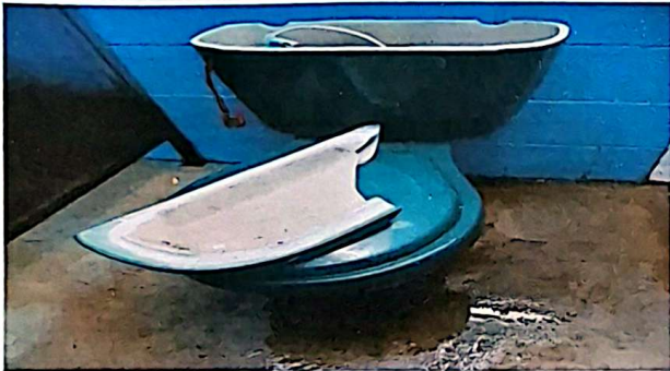
Foto 9: Sustitución de 1 inodoro elongado en módulo 1
