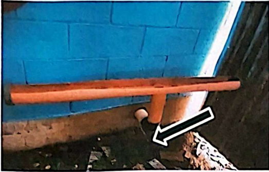
Foto 7: Instalación de 5 mts. de tubería PVC. Línea principal para migitorio 4" con recubrimiento de concreto en módulo 1
