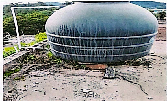
Foto 6: Sustitución de 1 deposito de agua 2500 lts. Más instalación en módulo 1
