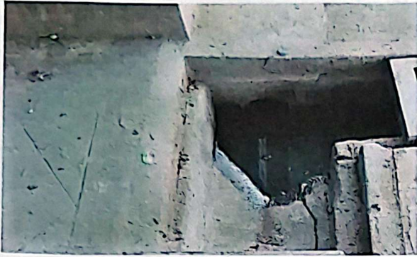
Foto1: Sustrucción de 16 Mts. de manejo de agua pluvial existente con tubo PVC. de 4" por manejo de agua pluvial con canal U de concreto y regía de metal en el módulo 1
