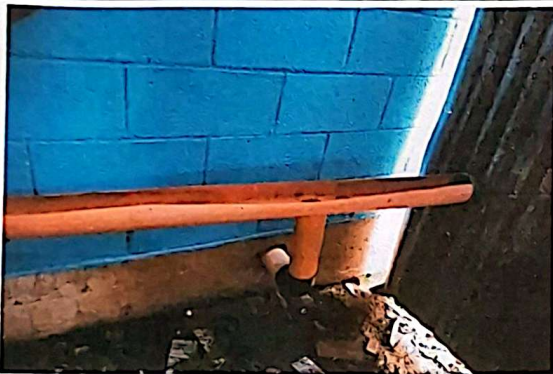
Foto 3: Mantenimiento a 1 migitorio con azulejo en baño, módulo 1
