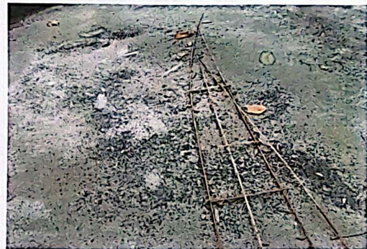
Foto 4: Mantenimiento correctivo de 86 Mts. Cuadrados de losa de concreto con nivelación de terraza para aplicación de impermeabilizante (relleno de grietas y desnivel) en módulo 2
