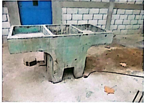
Foto 8: Sustitución de 1 pila en cocina en módulo 2
