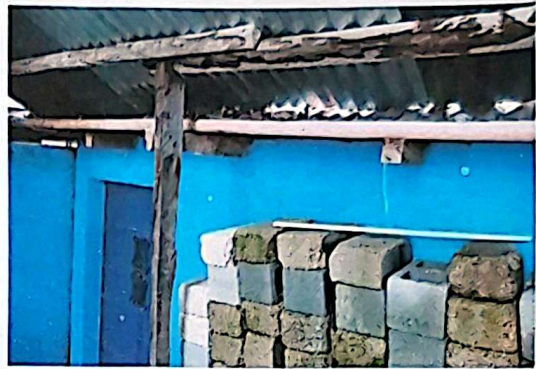
Foto 2: Sustotución de 22 Mts. de canal de PVC. Por canal de metal en módulo 1
