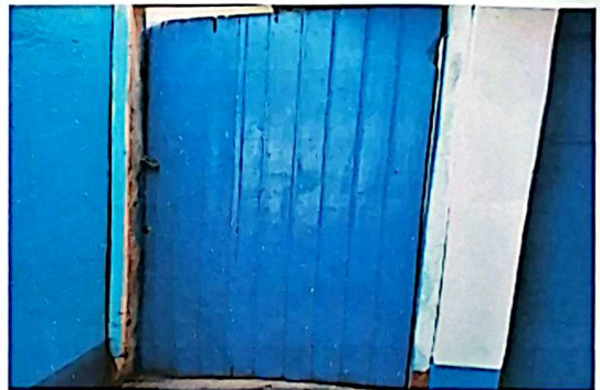
Foto 10: Sustitución de 1 puerta de bodega de madera por 1 puerta metálica en módulo 2
