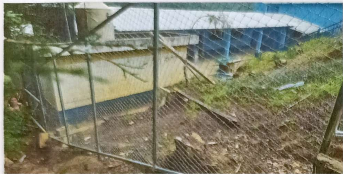
Foto 1. Sustrucción de 19 m2 de cerco perimetral con maya calibre 13 y tubo hg de 1 7/8 en módulo 2.
