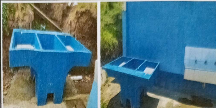
Foto 2. Sustrucción de 2 pilas de concreto en módulo 2.
