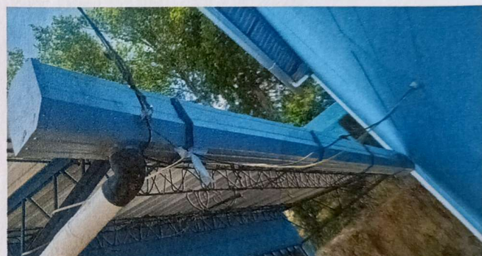
Foto 4. Sustrucción de 6 canales pluvial de bajada de agua en módulo 2.
