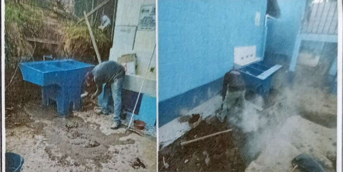
Foto 2: sustitución de 2 pilas de concreto en módulo 2.
