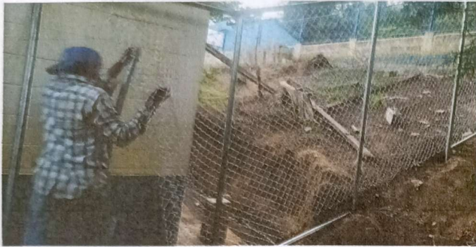
Foto 1: Sustitución de 19 m2 de cerco perimetral con maya calibre 13 y tubo hg de 1 7/8 en módulo 2.
