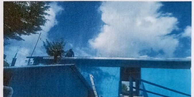
Foto 4: Sustitución de 6 canales pluvial de bajada de agua en módulo 2.
