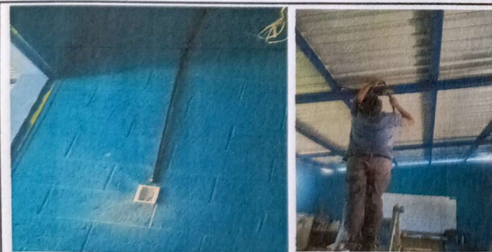
Foto 5: Sustitución de 3 tomacorrientes en módulo 2.
