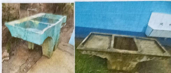
Foto 2: Sustrución de 2 pilas de concreto en módulo 2.
