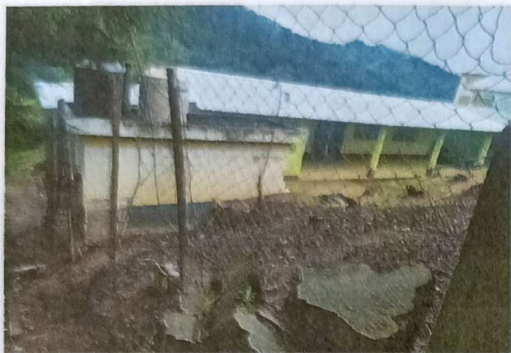
Foto 1: Sustrución de 19 m2 de cerco perimetral con maya calibre 13 y tubo hg de 1 7/8 en módulo 2.
