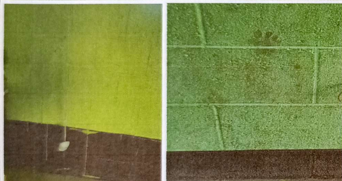
Foto 3: Suministro y aplicación de pintura sherwin williams de 763 m2 en muro interior y exterior y 89 m2 de zócalo interior y exterior módulo 2.
