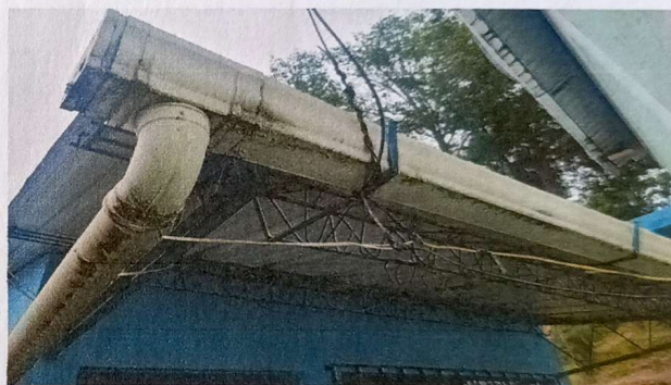
Foto 4: Sustrución de 6 canales pluvial de bajada de agua en módulo 2.
