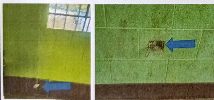
Foto 5: Sustrución de 3 tomacorrientes en módulo 2.
