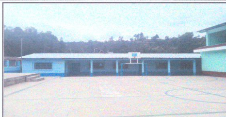
Foto 1: Suministro y aplicación pintura Exterior latex azul cenicienta pantone 293 para exteriores de aulas
