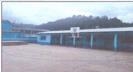
Foto 2: Suministro y aplicación pintura Exterior latex azul pantone 293 para zocalo
