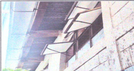
Foto 2 Sustrucción de ventana de metal por ventana con marco de metal
