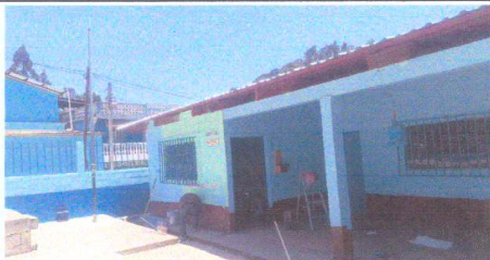
Foto 2: Suministro y aplicación pintura Exterior latex azul pantone 293 para zocalo
