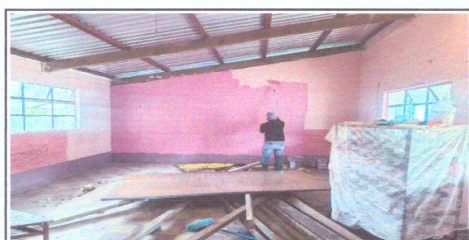
Foto 3: Suministro y aplicación pintura interior latex lavable rosado linaje pantone 293 limpieza resane y aplicación.
