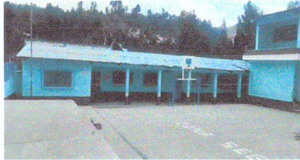
Suministro y aplicación pintura Exterior latex azul cenicienta pantone 293 para exteriores de aulas
