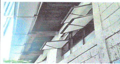
Sustitución de ventana de metal por ventana con marco de metal
