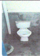
Sustitución de inodoros elongados
