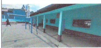
Suministro y aplicación pintura Exterior latex Azul pantone 293 para zócalo
