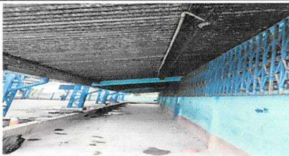
sustitución de lámina canalada por lámina troquelada de calibre 26 en Módulo 1
