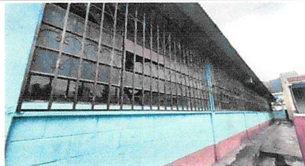
Matenimiento en balcones ( Lijado y pintado) con pintura anticorrosiva en Módulo 1,3,4 y 5
