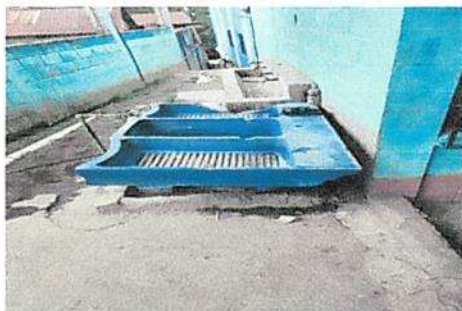
Sustitucion de pila de cemento de dos lavaderos en Módulo 1
