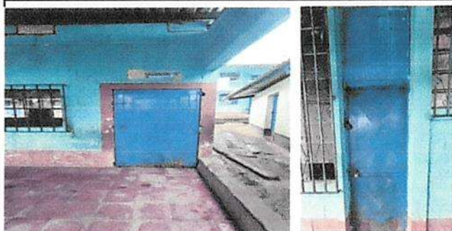
Mantenimiento de puerta (lijado y pintado) con pintura anticorrosiva en Módulo 1 al 6
