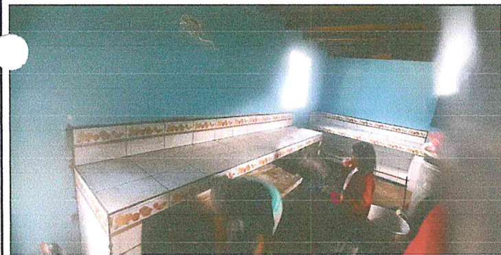
Foto 5: Sustitución de 1 mesa de trabajo por mesa de concreto en cocina, módulo 1.
