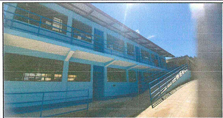
Foto 1: Suministro y aplicación de pintura exterior a 160 metros cuadrados, para muros y losa de corredor, módulo 3.
