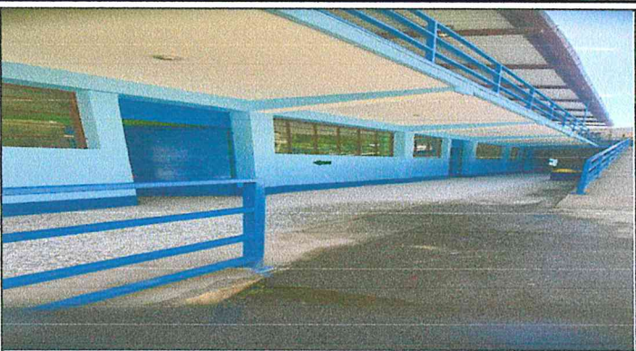
Foto 2: Suministro y aplicación de pintura exterior a 17 metros cuadrados de zócalo, módulo 3.
