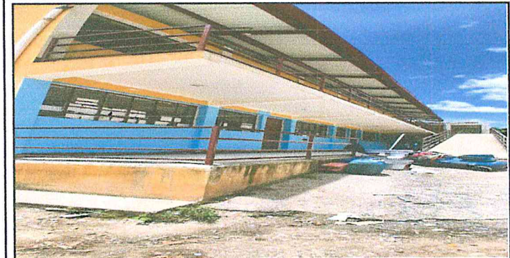
Foto 1: Suministro y aplicación de pintura exterior a 160 metros cuadrados, para muros y losa de corredor, módulo 3.
