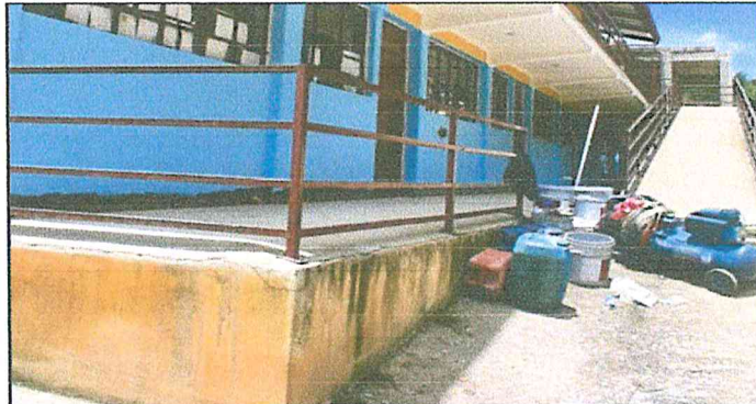
Foto 4: Mantenimiento en baranda de metal de 50 metros cuadrados, con pintura secado rápido, módulo 3.
