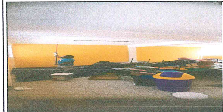
Foto 3: Suministro y aplicación de pintura interior en 501 metros cuadrados para muros más losa interior de terraza, módulo 3
