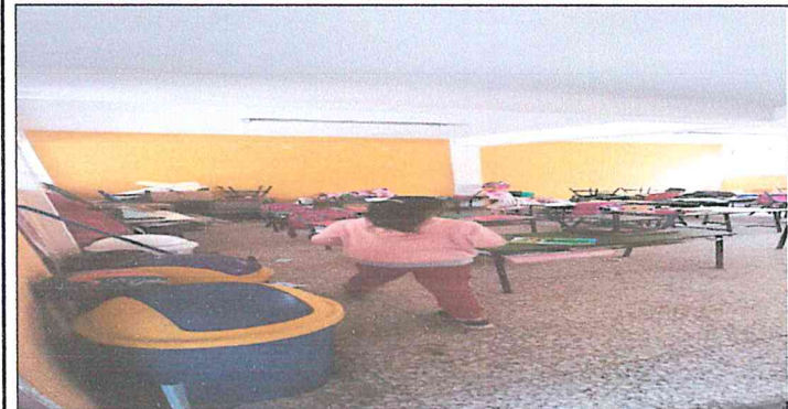
Suministro y aplicación de pintura interior en muros más losa interior de terraza, modulo 3
