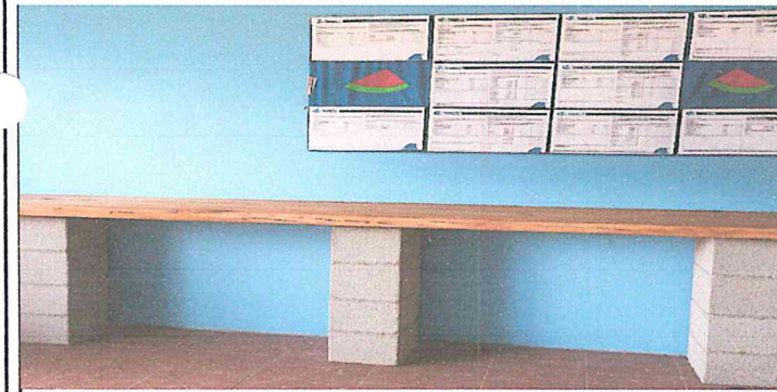
Sustitución de mesa de trabajo por mesa de concreto en cocina, modulo 1
