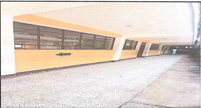
Suministro y aplicación de pintura exterior a zócalo, modulo 3
