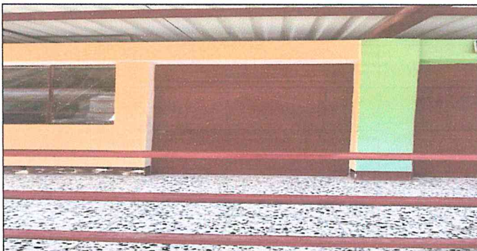
Mantenimiento a puertas de metal con pintura secado rapido, modulo 3
