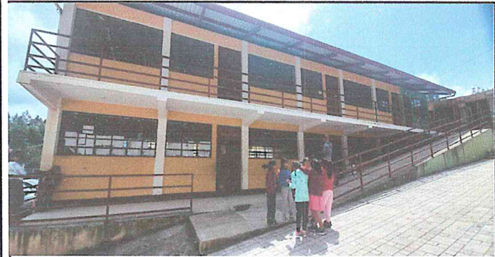
Suministro y aplicación de pintura exterior para muros y losa de corredor, modulo 3.
