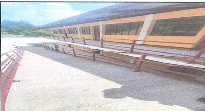
Mantenimiento de baranda de metal con pintura secado rápido, modulo 3
