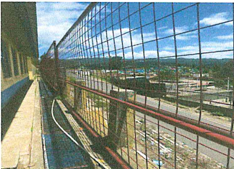
Circulación con malla electrosoldada de 6x6 pulgadas de abertura, calibre 4.5 corrugada, tubo proceso original de 1.5 pulgadas y con pintura anticorrosiva
