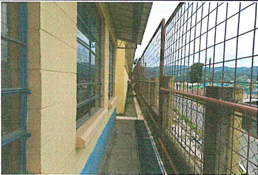
Circulación con malla electrosoldada de 6x6 pulgadas de abertura, calibre 4.5 corrugada, tubo proceso original de 1.5 pulgadas y con pintura anticorrosiva
