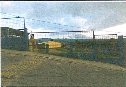
Circulación con malla electrosoldada de 6x6 pulgadas de abertura, calibre 4.5 corrugada, tubo proceso original de 1.5 pulgadas y con pintura anticorrosiva
