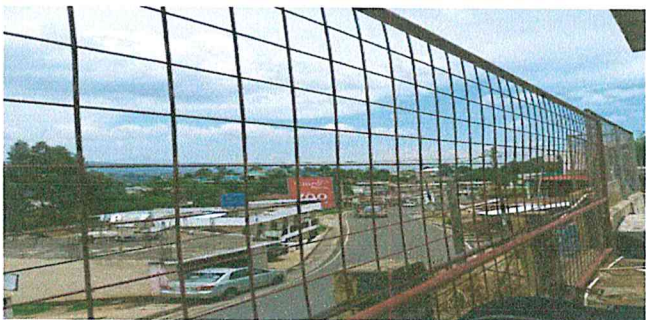
Instalación de circulación con malla electrosoldada de 6x6 pulgadas de abertura, calibre 4.5 corrugada, tubo proceso original de 1.5 pulgadas y con pintura anticorrosiva
