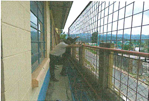
Instalación de circulación con malla electrosoldada de 6x6 pulgadas de abertura, calibre 4.5 corrugada, tubo proceso original de 1.5 pulgadas y con pintura anticorrosiva
