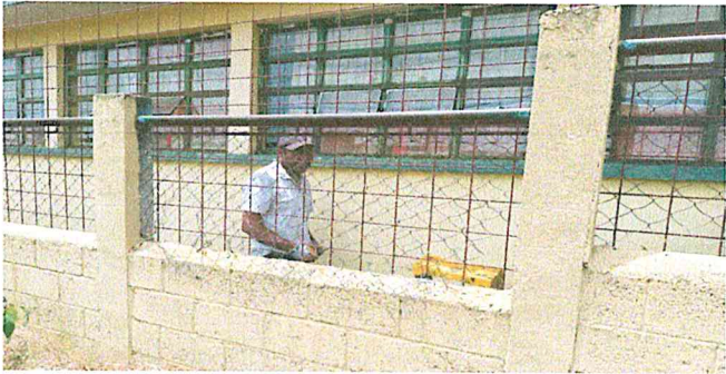
Instalación de circulación con malla electrosoldada de 6x6 pulgadas de abertura, calibre 4.5 corrugada, tubo proceso original de 1.5 pulgadas y con pintura anticorrosiva
