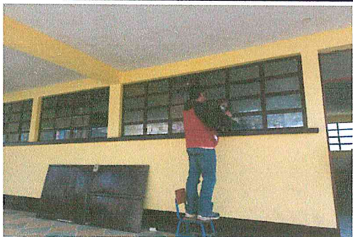
Instalación de 2 vidrios claros de 5 milímetros
