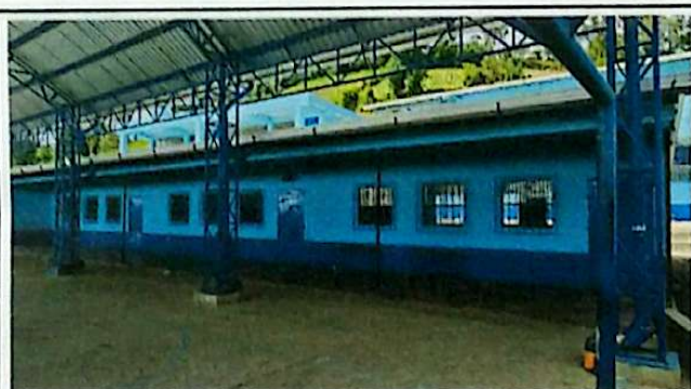
Foto 3: FINAL DE PINTURA DE INSTALACIONES EXTERIORES
