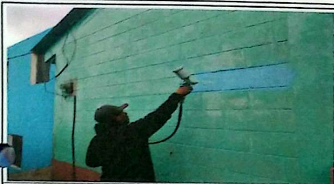
Foto1: PINTURA DE EXTERIOR DE AULAS
