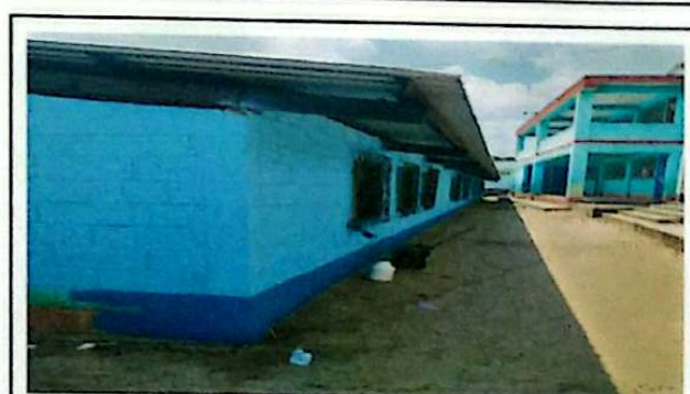
Foto 4: inicio de pintura de zócalo
