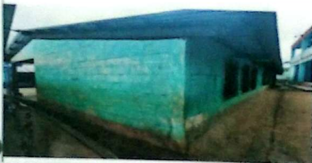
Suministro y aplicación de Pintura exterior Celeste Pantone 293 para muros en Módulo 1,3,4,5,y6
