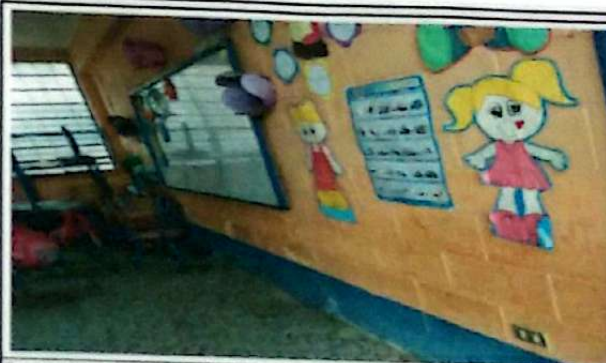
Suministro y Aplicación de pintura interior muro Latex Lavable (limpieza resane y aplicación ) en Módulo 1,3,4,5,y 6
