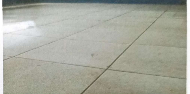
Sustitución y aplicación de piso ceramico de 214m² en 4 aulas modulo 1
