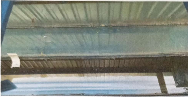
Sustitución de dos vidrios claros de 5 mm.
