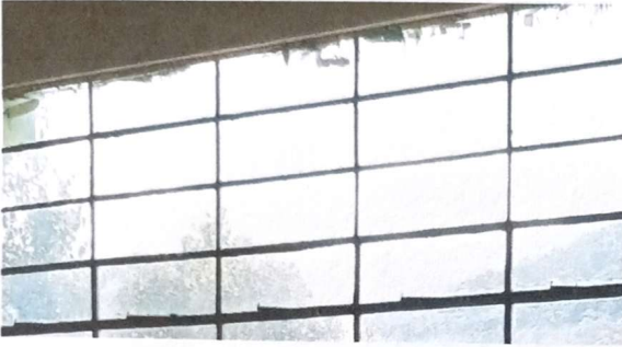
Sustitución de dos vidrios claros de 5 mm.
