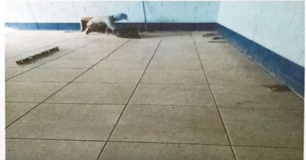
Sustitución y aplicación de piso ceramico de 214m² en 4 aulas modulo 1
