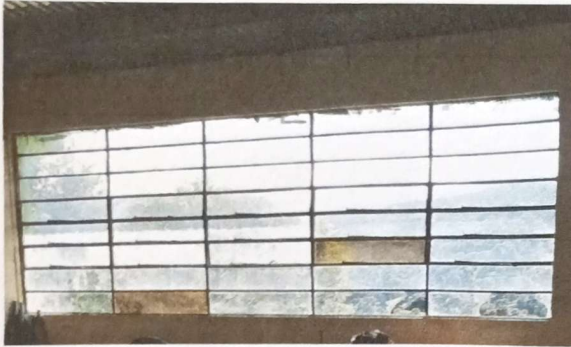
Sustitución de dos vidrios claros de 5 mm
