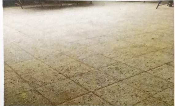
Sustitución y aplicación de piso ceramico de 214m² en 4 aulas modulo 1
