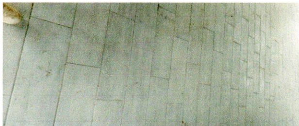
Foto 1: sustitución de piso concreto a piso cerámico en cuatro aulas de módulo 1 y cocina
