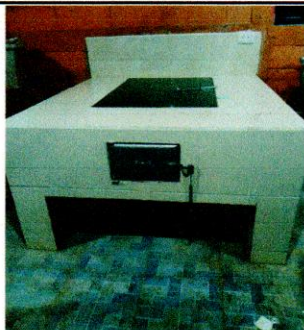
Foto 3: Sustitución de estufa en cocina con ladrillo y chimenea
