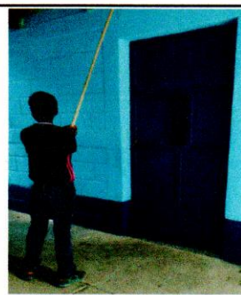
Foto 4: suministro y aplicación de pintura exteriores latex en cocina
