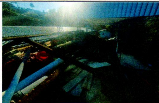
Foto 2: Sustitucion de lámina por lámina troquelada calibre 26 sobre cocina.
