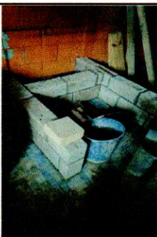
Foto 3: Sustitución de estufa en cocina con ladrillo y chimenea.
