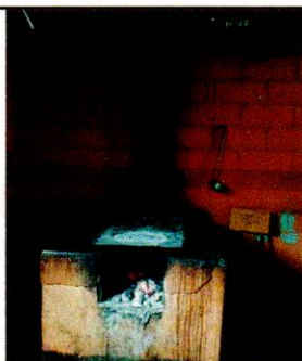
Foto: 3 Sustrución de estufa en cocina con ladrillo y chimenea .
