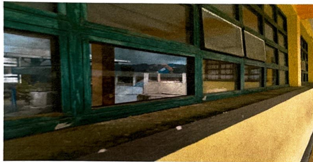
Foto 9: sustitución de 36 vidrios en módulo 1
