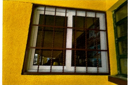
Foto 8: Sustitucion de ventana de metal a UPVC 1.20 mts con balcón en módulo 1
