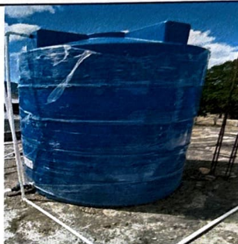
Foto 4: sustitución de 1 depósito de agua de 2500 litros en módulo 2
