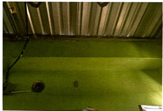
Foto 10: mantenimineto preventivo de muros 30 mts2 con aplicación de espuma en pared de cocina
