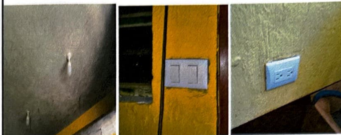
Foto 2: Sustitución de 32 plafoneras, 7 apagadores, 12 tomacorrientes y 36 focos en los módulos 1 y 2
