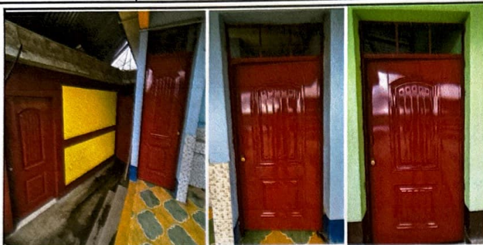
Foto1: Sustitución de 6 puertas de metal con tubo cuadrado de 1.5 pulgadas con lamina estampada 3/64 módulo 1
