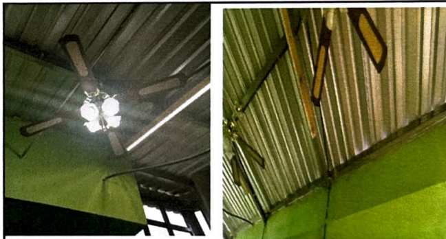
Foto 6: sustitución de 2 lamparas en cocina, módulo 2
