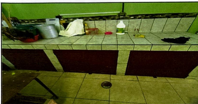
Foto 3: sustitución de 6 puertas de gabinetes en cocina
