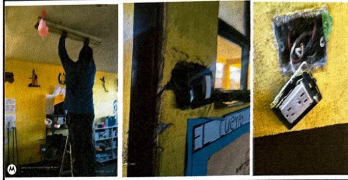
Foto 2: Sustitución de 32 plafoneras, 7 apagadores, 12 tomacorrientes y 36 focos en los módulos 1 y 2
