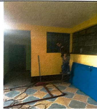
Foto 8: Sustitución de ventana de metal a UPVC 1.20 mts con balcón en módulo 1
