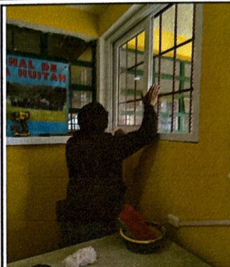
Foto 8: Sustitución de ventana de metal a UPVC 1.20 mts con balcón en módulo 1
