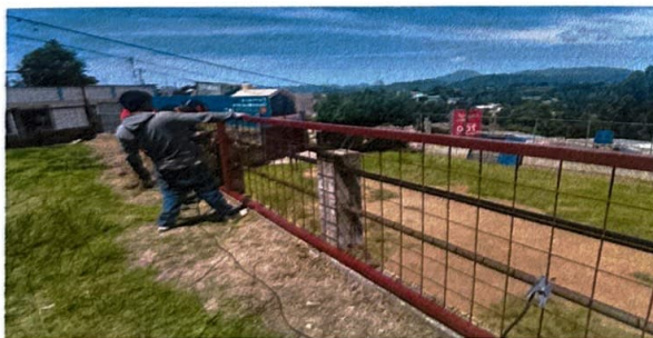
Foto 5: sustitución de 26 mts 2 cerco perimetral en muros del módulo 1
