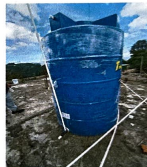
Foto 4: sustitución de 1 depósito de agua de 2500 litros en módulo 2
