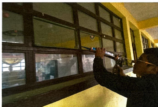
Foto 9: sustitución de 36 vidrios en módulo 1
