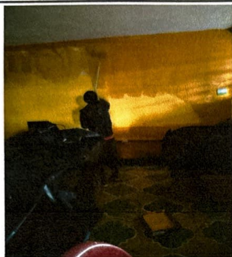
Foto 7: mantenimiento de muro con suministro y de aplicación de 186 mts de pintura en módulos 1 y 2
