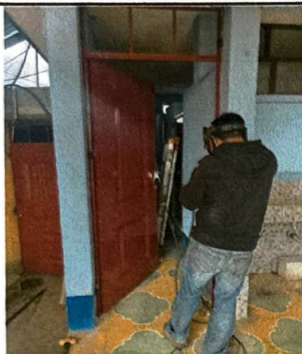
Foto 1: Sustitución de 6 puertas de metal con tubo cuadrado de 1.5 pulgadas con lamina estampada 3/64 módulo 1
