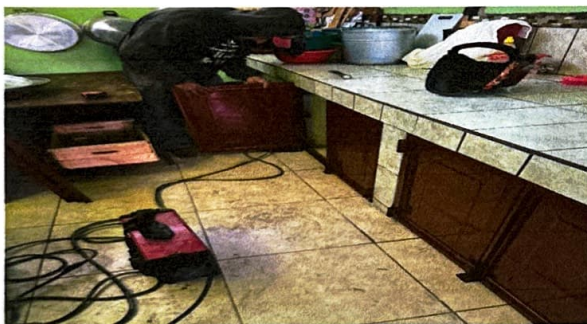
Foto 3: sustitución de 6 puertas de gabinetes en cocina
