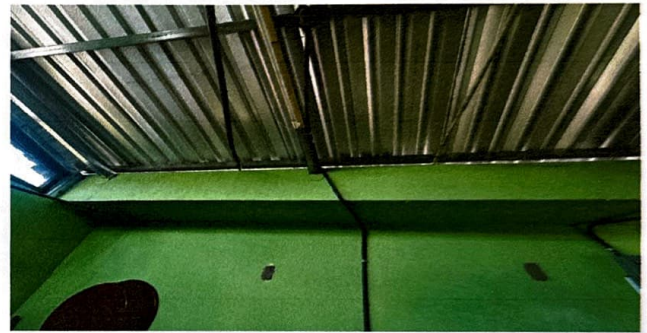
Foto 10: mantenimineto preventivo de muros 30 mts2 con aplicación de espuma en pared de cocina
