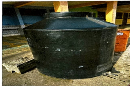
Foto 4: sustitución de 1 depósito de agua de 2500 litros en módulo 2
