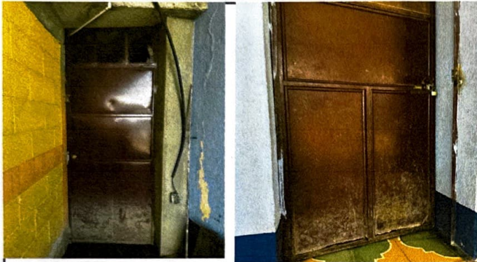
Foto 1: Sustitución 6 de puertas de metal con tubo cuadrado de 1.5 pulgadas con lamina estampada 3/64 módulo 1
