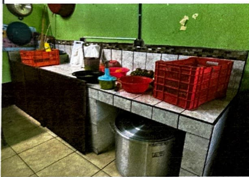
Foto 3: sustitución de 6 puertas de gabinetes en cocina
