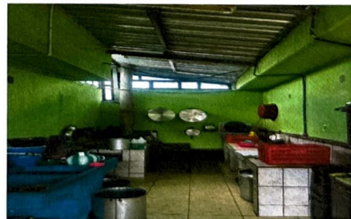
Foto 6: sustitución de 2 lamparas en cocina, módulo 2
