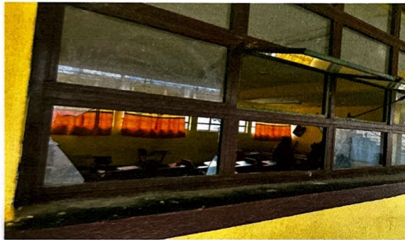
Foto 9: sustitución de 36 vidrios en módulo 1
