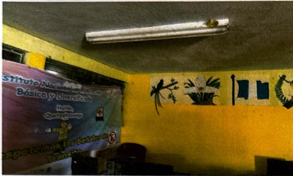
Foto 7: mantenimineto de muro con suministro y de aplicación de 186 mts de pintura en módulos 1 y 2
