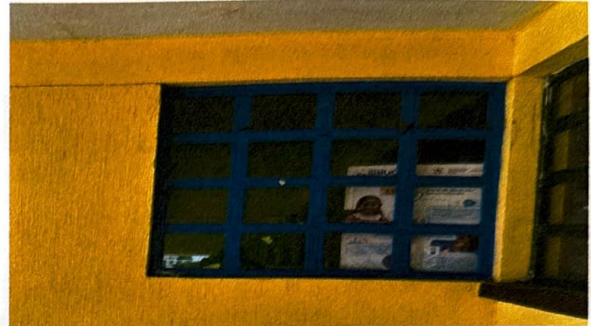
Foto 8: Sustitución de ventana de metal a UPVC 1.20 mts con balcón en módulo 1
