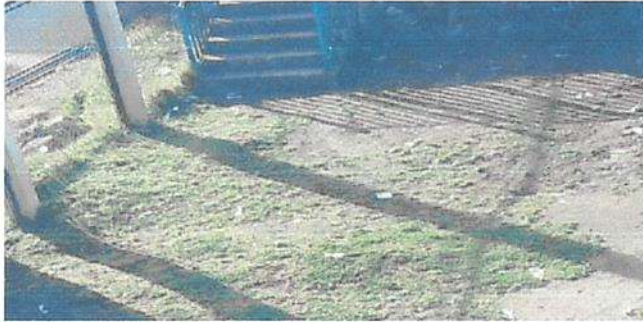
Sustitución de reposaderas 6" x 6" para patios en módulo 3
