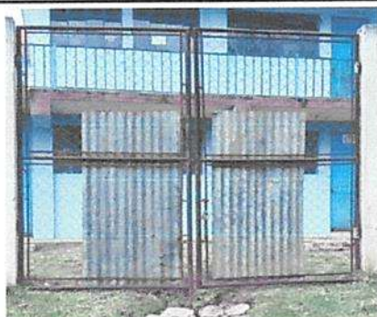
Sustitución de portón Metálico en entrada de módulo 3.
