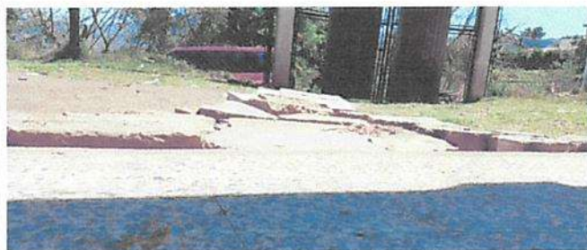
Sustitución de piso por adoquin tráfico liviano en módulo 3
