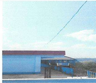
Reparación de cableado eléctrico calibre 6AWG en módulo 3
