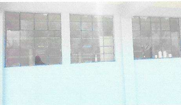
Sustitución de balcones en módulo 3.
