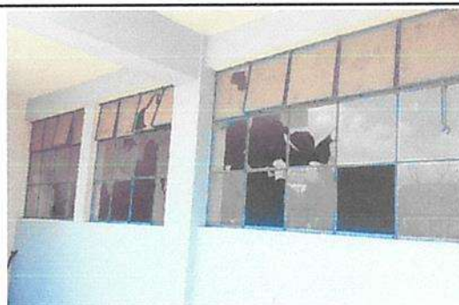
Sustitución de vidrios de 5mm en módulo 3.
