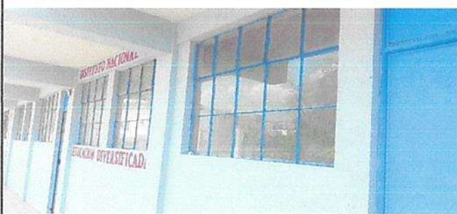
Suministro y aplicación pintura exterior latex Azul Pantone 293 para zócalo 4 hiladas en módulo 3
