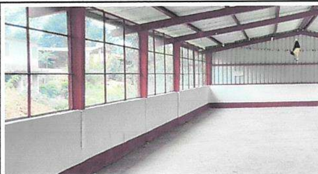
Sustitución de balcones con tubo de 3/4 chapa 18 en módulo 2
