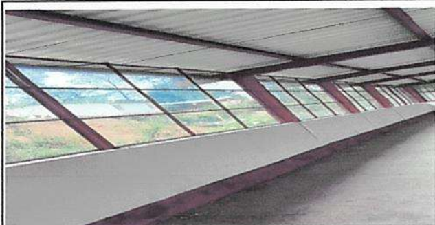
Sustitución estructura de metal de ventanas con vidrio transparente en modulo 2
