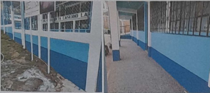
Foto1: Suministro pintura exterior, zócalo, módulo 2
