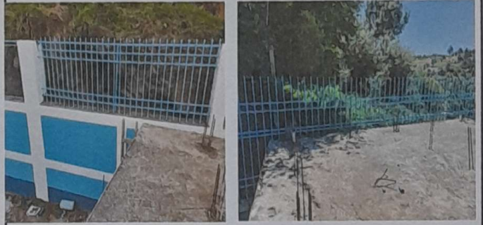
Foto 4: Sustitución de malla por barandas de metal, módulo 2
