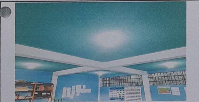
Sustitución de foco, aula de cuarto, módulo 2
