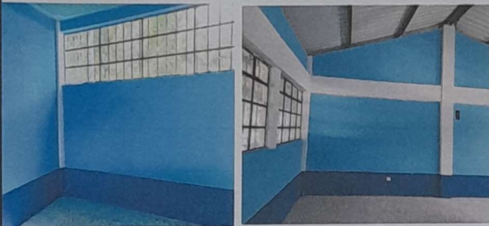
Foto 3: Suministro pintura interior en todas las instalaciones, módulo 2
