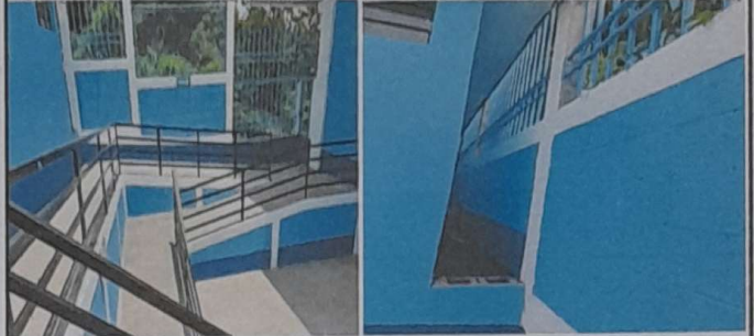
Foto 2: Suministro pintura exterior para muros, en todas las instalaciones, módulo 2
