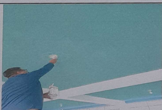
Foto 5: Sustitución de foco en aula de cuarto, módulo 2
