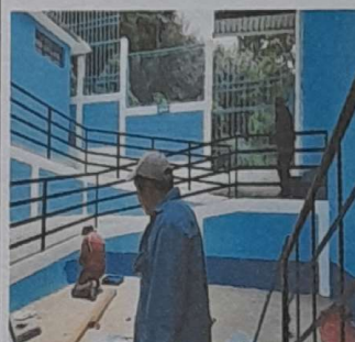
Foto 2: Suministro pintura exterior, módulo 2
