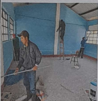
Foto 3: Suministro pintura interior, módulo 2
