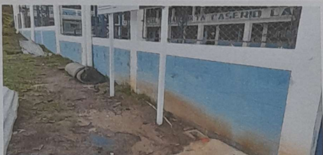
Suministro pintura exterior, para zócalo, módulo 2
