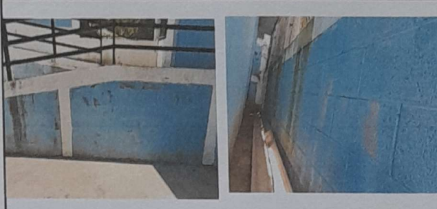
Suministro pintura exterior e interior en todas las instalaciones, módulo 2
