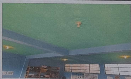
Sustitución de un foco en aula de cuarto, módulo 2
