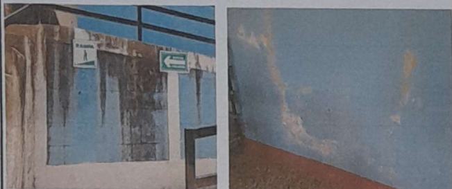
Suministro pintura exterior e interior en todas las instalaciones, módulo 2
