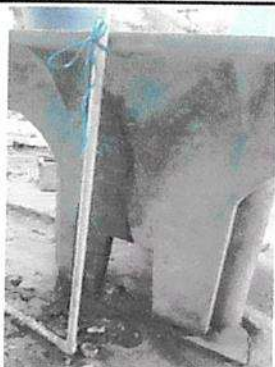
Sustitución de pila de concreto
