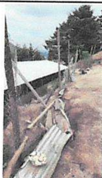
Sustitución de cerco perimetral metálico
