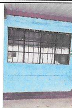
Suministro y aplicación de pintura exterior latex para aulas
