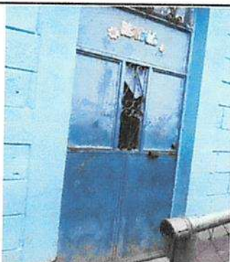
Mantenimiento de puertas de metal para aulas, cocina y una bodega
