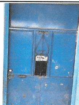
Sustitución de chapas Yale para sobreponer en aulas de módulo 1
