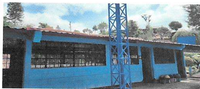
Sustitución de canal de metal en módulo 1
