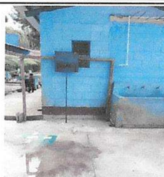
Sustitución de marco de metal para porteria con tablero y canastas para basquetbol
