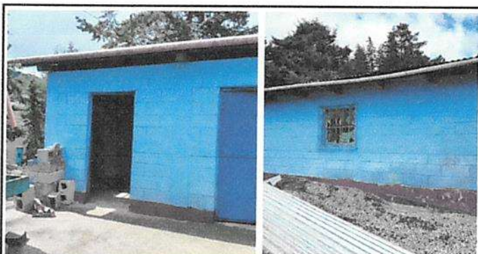
Sustitución de canal de metal en ambos lados de baño y cocina
