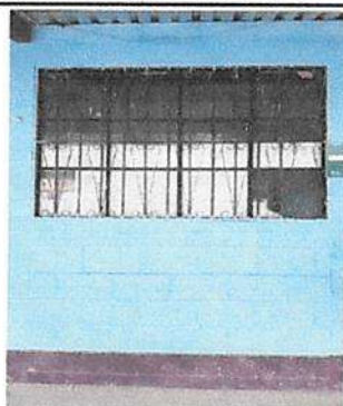
Mantenimiento de balcón de metal en pasillo del módulo 1 (lijado y pintado)
