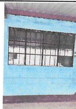
Mantenimiento de estructura de metal de ventanas en módulo 1
