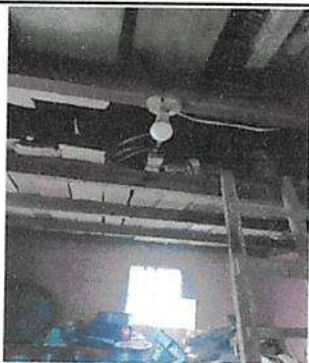
Mantenimiento de cable eléctrico en cocina y corredor de cocina
