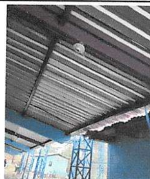
Mantenimiento de luminaires ( 4 plafoneras, 4 focos y 4 tomas de corriente)
