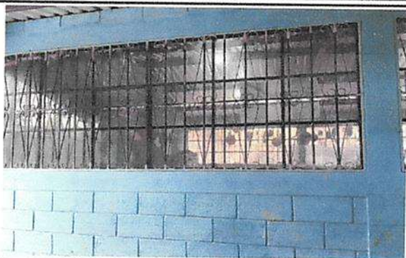
Sustitución de vidrio claro de 5 mm en aulas de módulo 1
