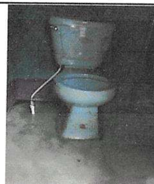
Sustitución de inodoros elongados
