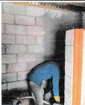
DE ESA MANERA SE FUE APLICANDO REPELLO A LAS PAREDES DE LOS SERVICIOS SANITARIOS
