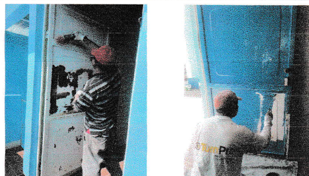
SE LE ESTA APLICANDO PINTURA A LAS PUERTAS
