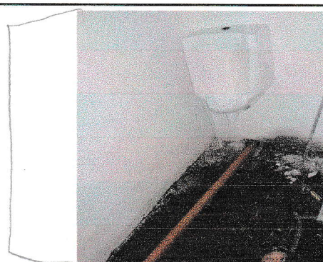
AQUÍ SE PUEDE EVIDENCIAR QUE SE ESTABA TRABAJANDO EN LA INSTALACION DEL NUEVO MIGITORIO
