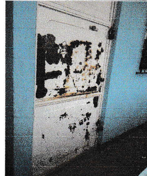
Reparación y mantenimiento de puertas (recortar, lijar, soldar y aplicación de pintura)
